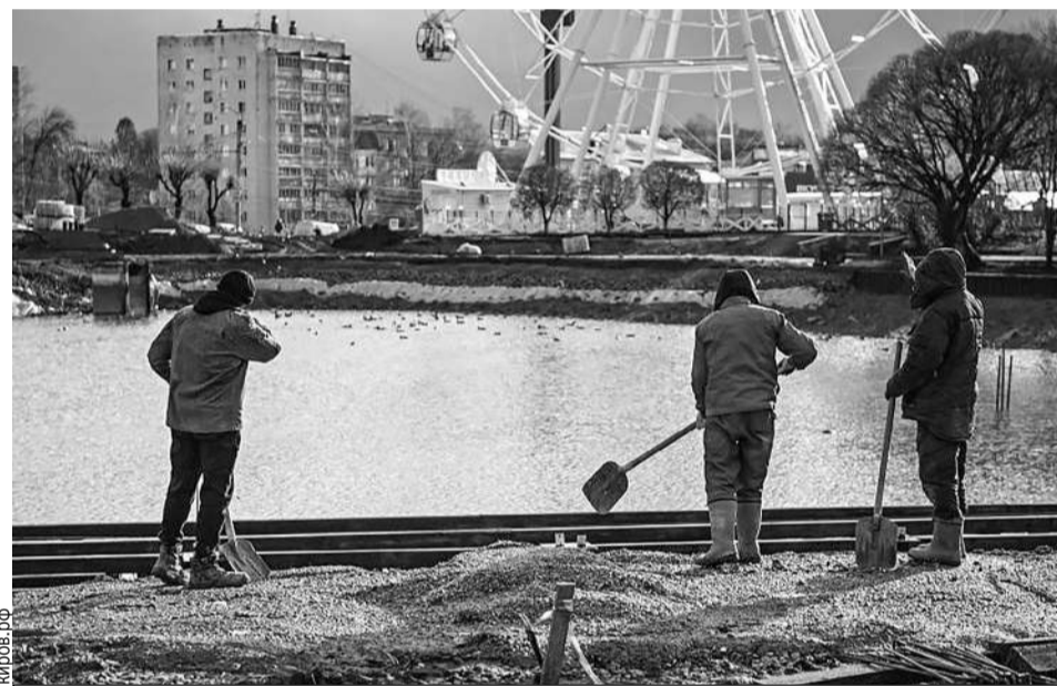
Чтобы успеть в срок, на объект выводят дополнительные бригады рабочих.
