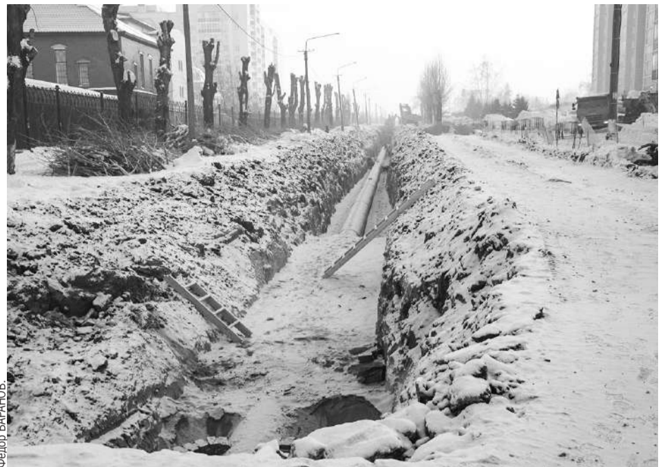
Все работы под землей планируют завершить до конца весны, чтобы летом сосредоточиться на дорогах и тротуарах.
