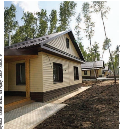
Это уже готовый объект. Осталось благоустройство.
