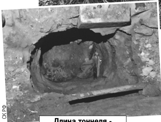
Длина тоннеля - около 65 метров.
