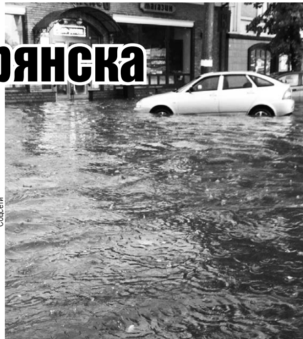
На Набережной залило первые этажи и подвалы зданий.
