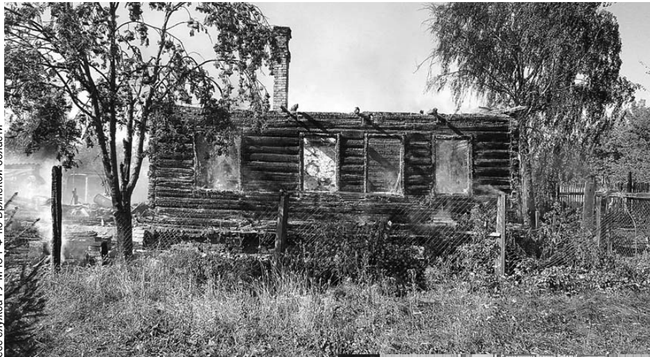
Деревянный дом и сарай сгорели дотла.
