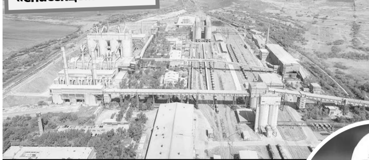
Новоспасский цементный завод с высоты птичьего полета.
