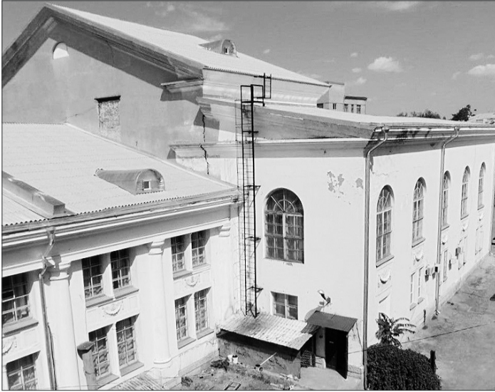
На данный момент в театре рабочие красят лестницу и вывозят строительный мусор.
