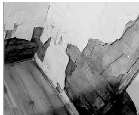
Постоянно текущая водопроводная вода рушит дома шахтинцев.
