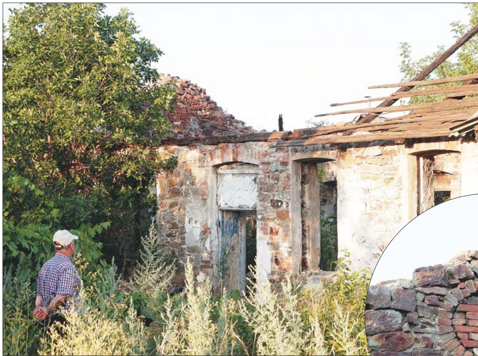
Развалины здания на старом руднике Кошкина, в котором, предположительно, была Школа кочегаров.
