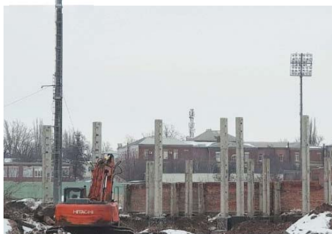
Стадион Шахтер является одним из объектов контроля «Шахтстройзаказчика».
