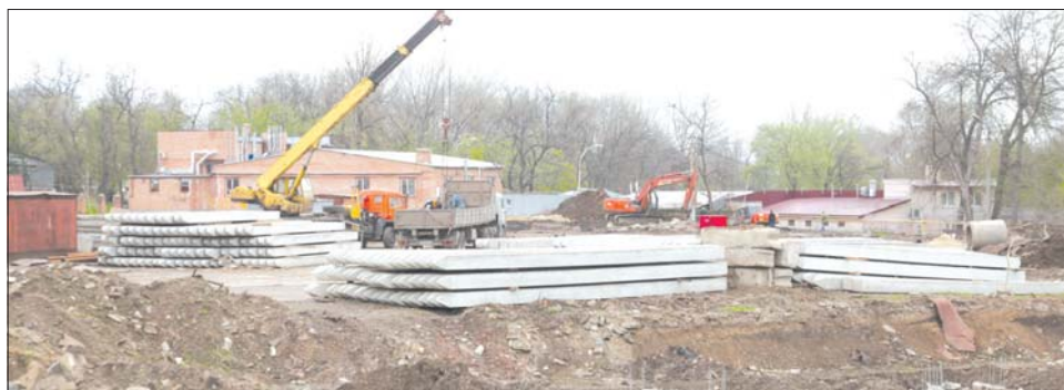
Строительство стадиона «Шахтер» затянется до 2019 года. Фото из архива редакции.
