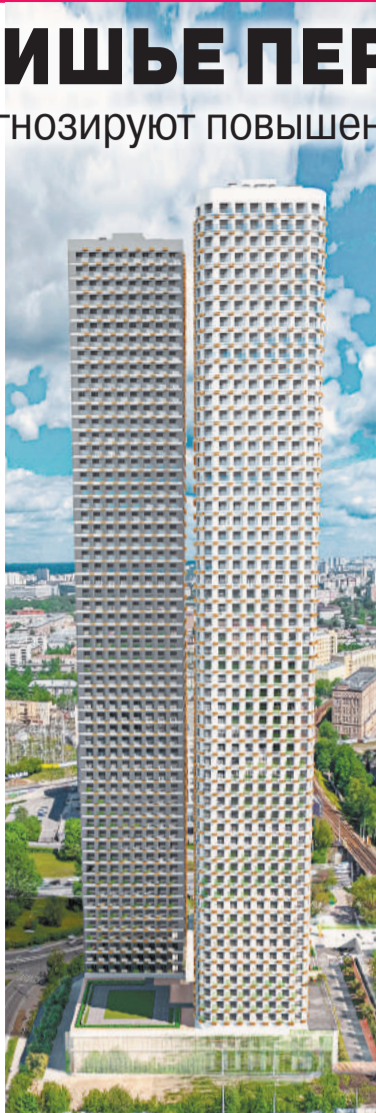
Близко к центру Москвы, у станции метро «Дмитровская», скоро вырастет комплекс из 23-этажного корпуса и двух 59-этажных небоскрёбов.
