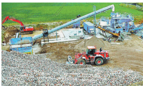
Из старого бетона научились делать новый.
