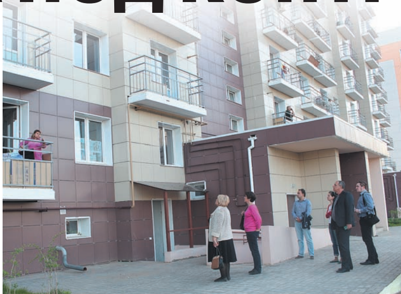
Дом на ул. Грановского в Астрахани ввели в эксплуатацию в феврале. Сейчас он полон жильцов - все довольны.
